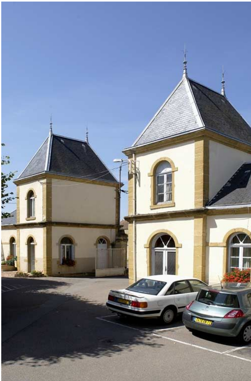
Pavillons d'entrée, vue générale depuis la cour.
