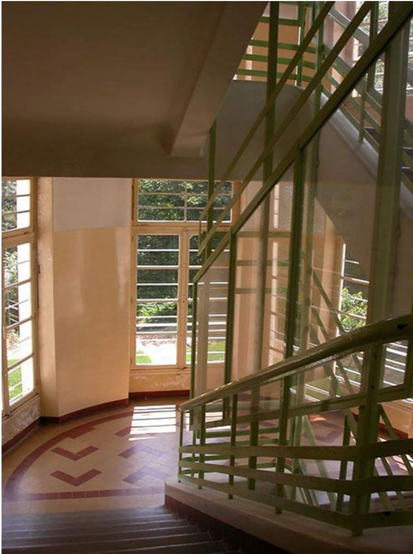
Aile des soins : vue intérieure de l'escalier.
