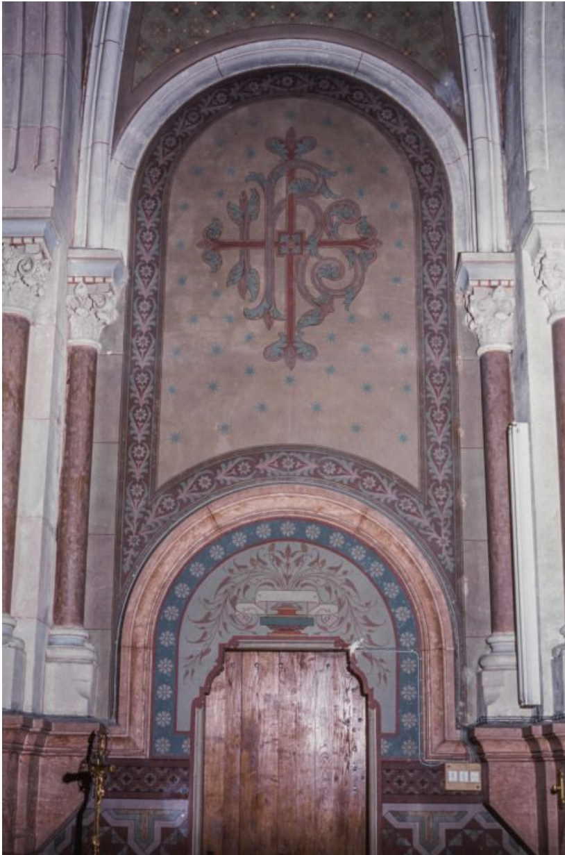
Chapelle, mur du transept droit.
