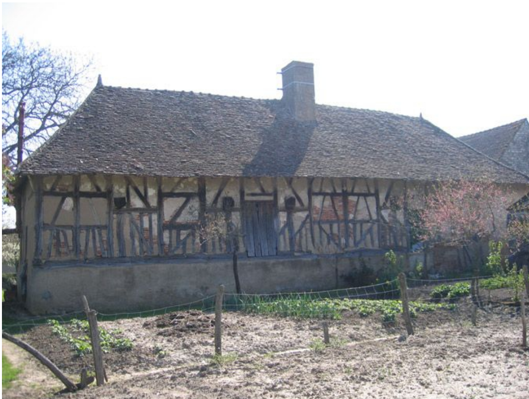
Vue d'ensemble de la façade postérieure.
