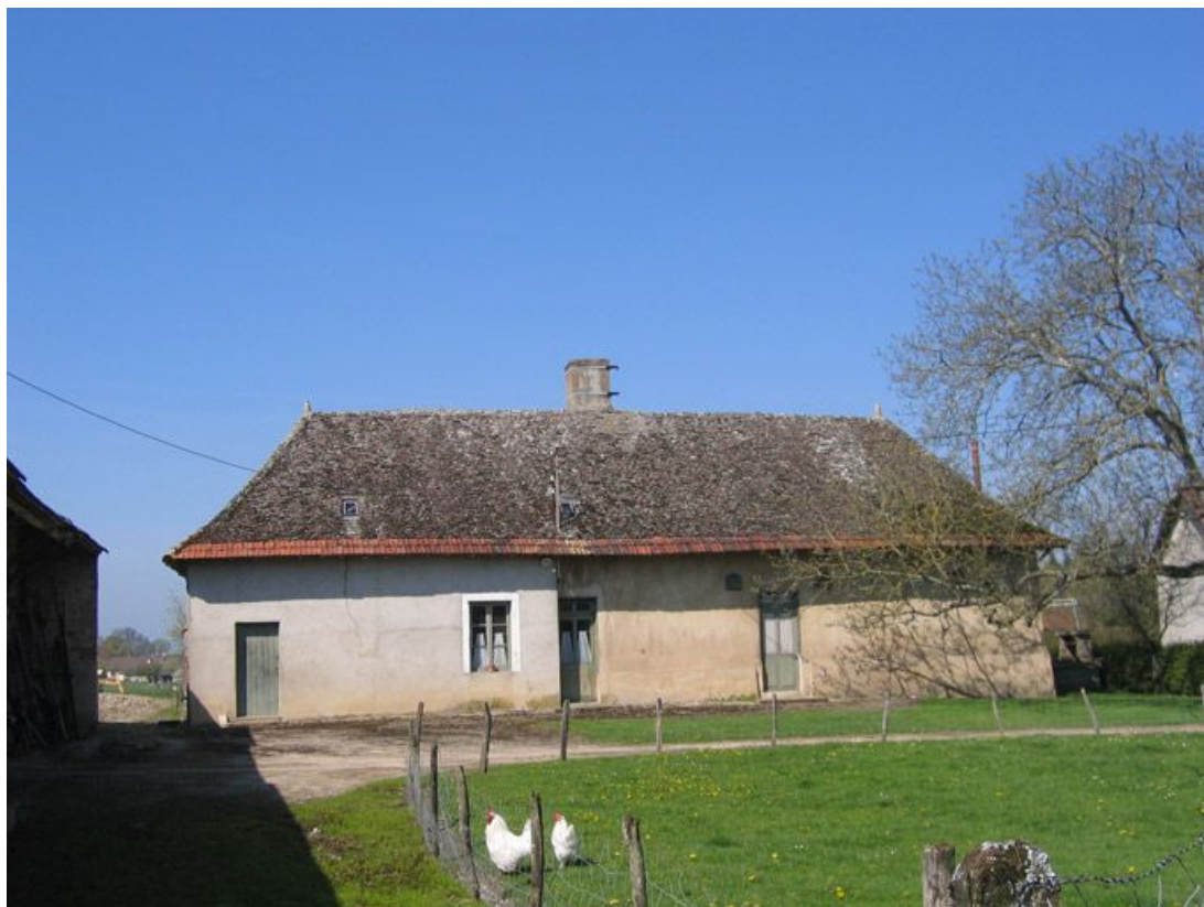
Vue d'ensemble de la façade antérieure.
