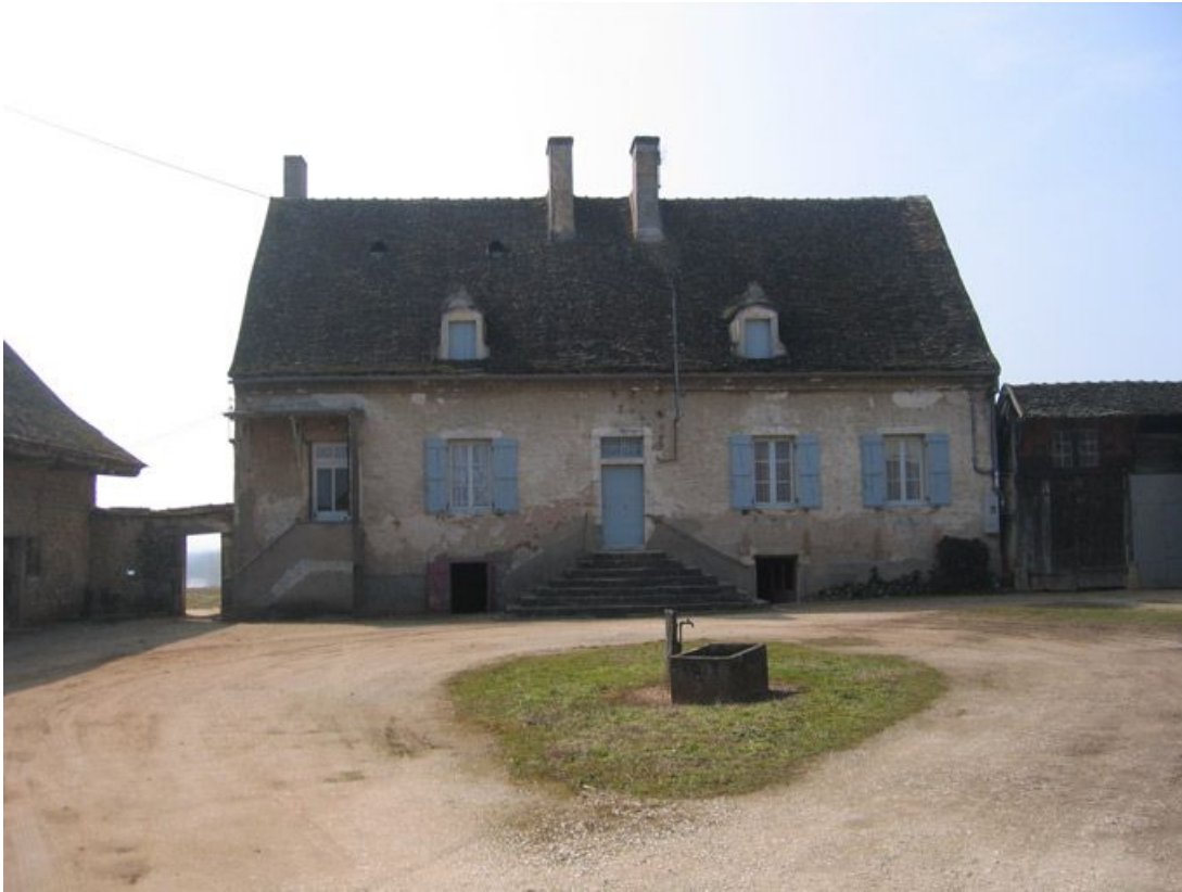
Vue d'ensemble de la façade de l'habitation.
