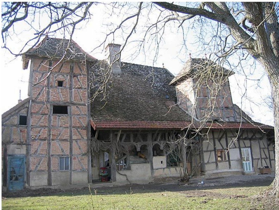
Vue d'ensemble de la façade.
