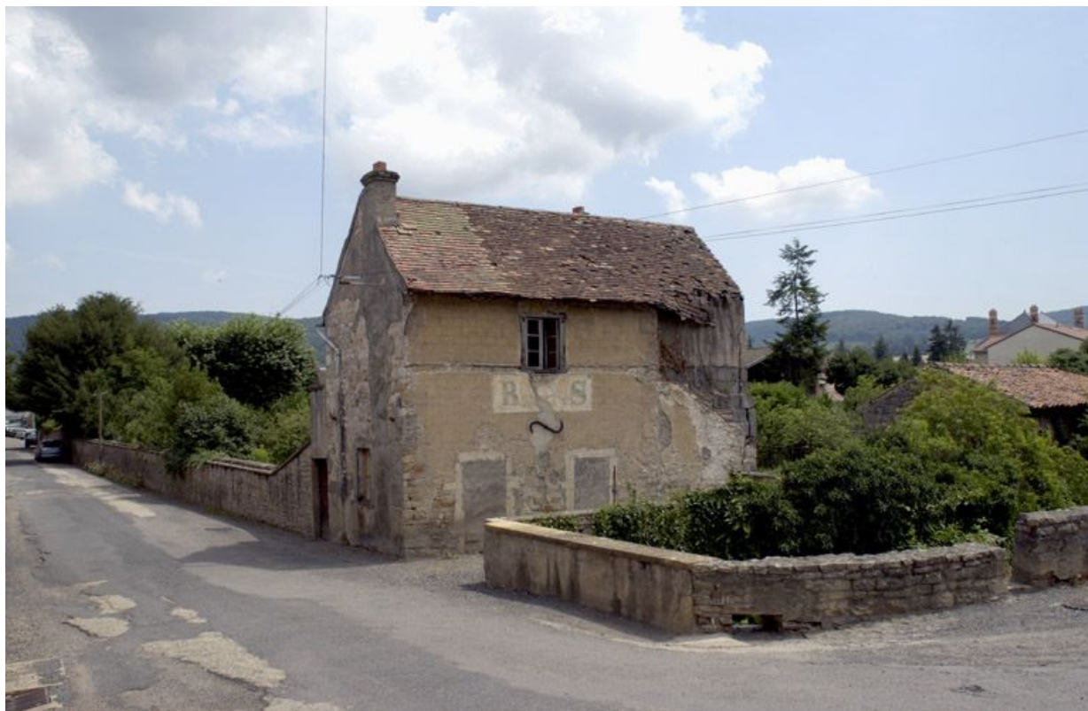
Anciens bains publics, bâtiment désaffecté.
