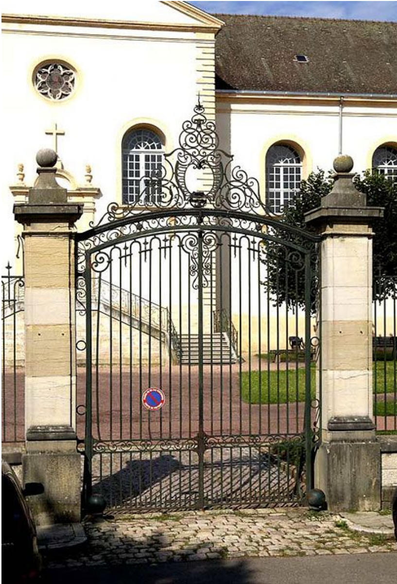
Détail de la grille d'entrée.
