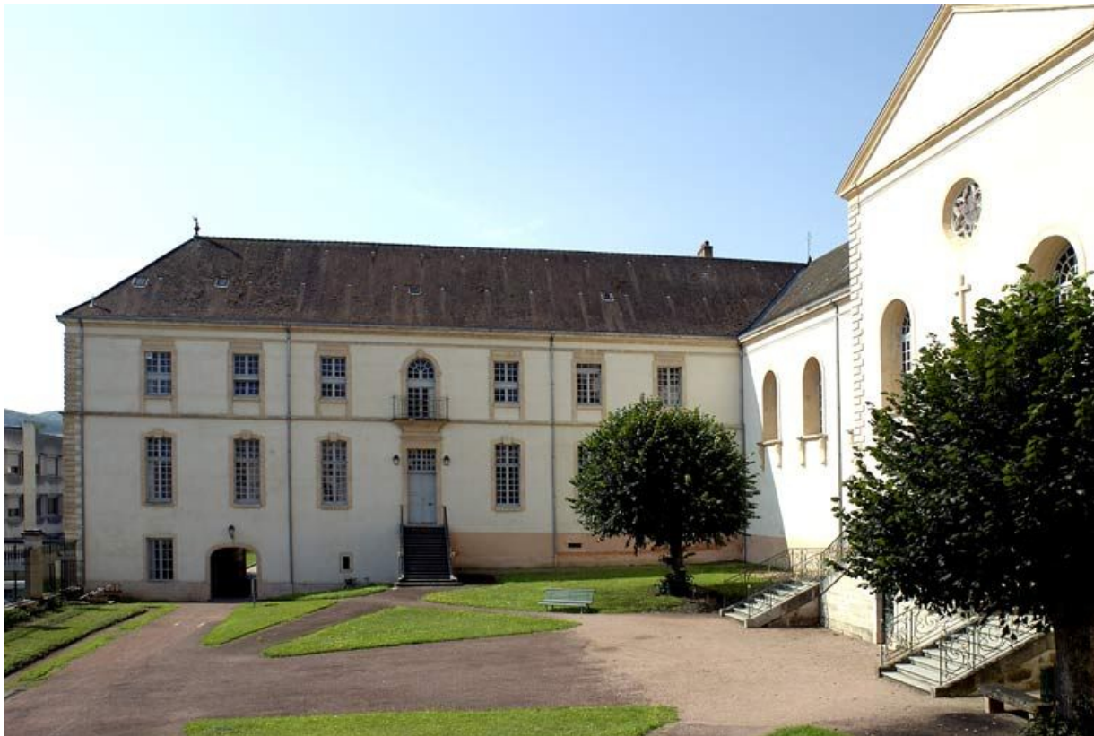
Aile gauche et bâtiment principal.
