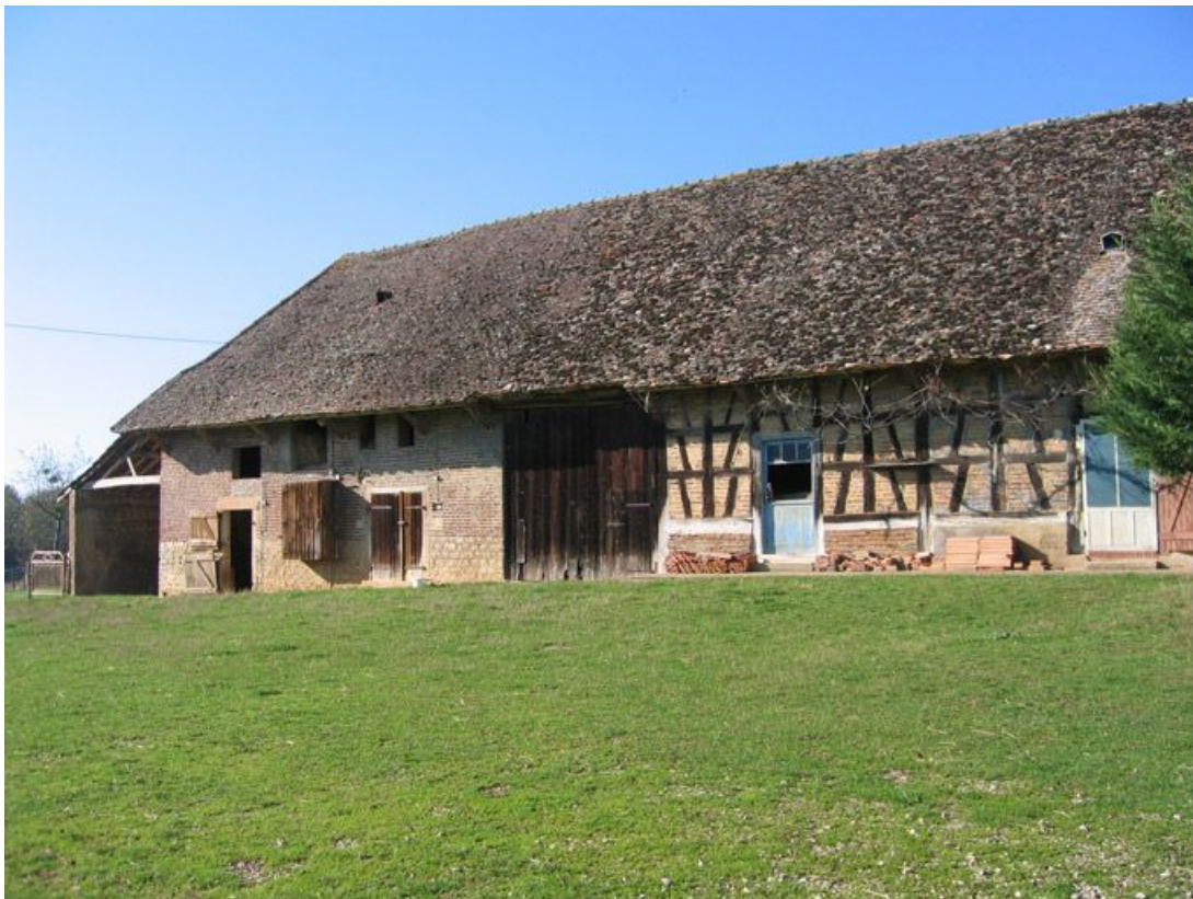
Vue d'ensemble de la façade des dépendances.
