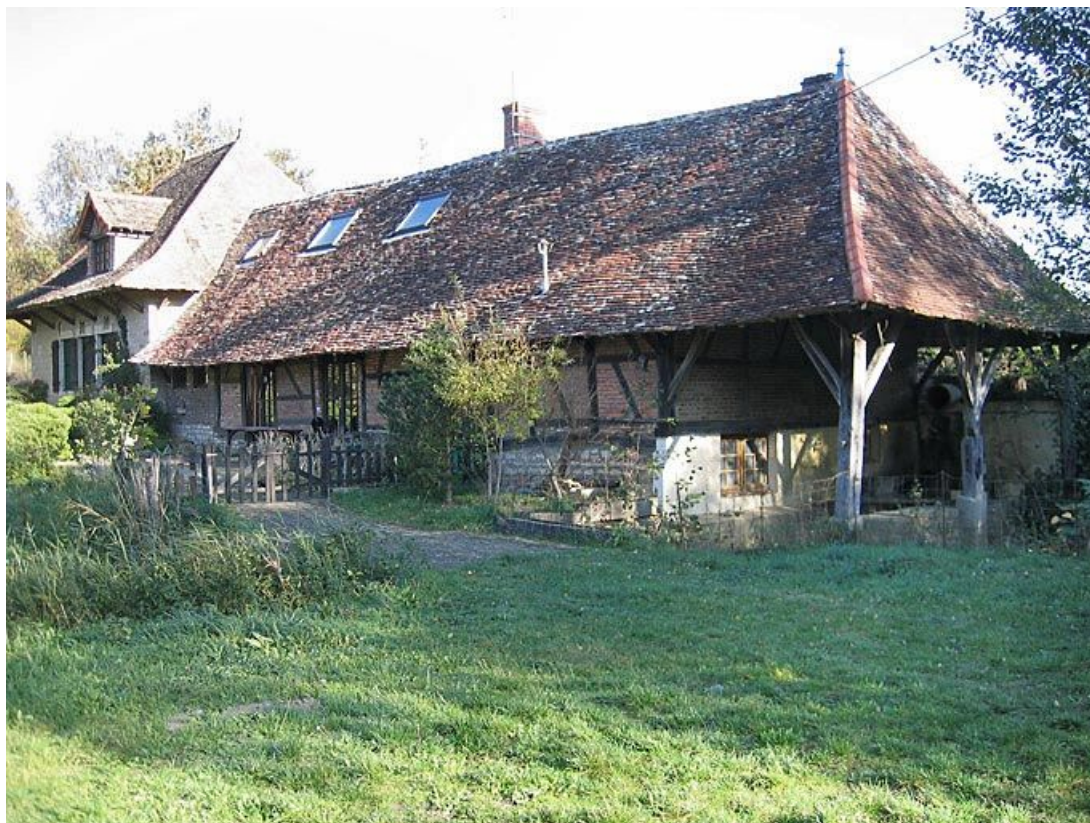
Vue d'ensemble de la façade de l'habitation.
