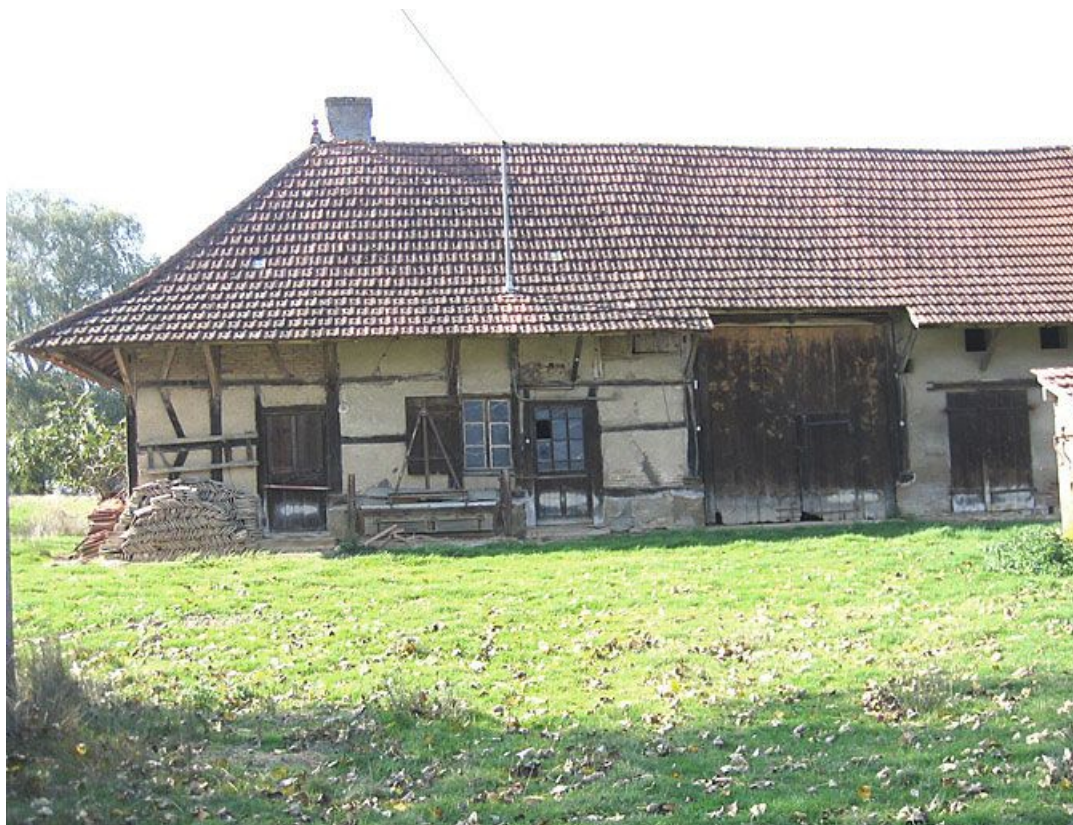
Vue d'ensemble de la façade.
