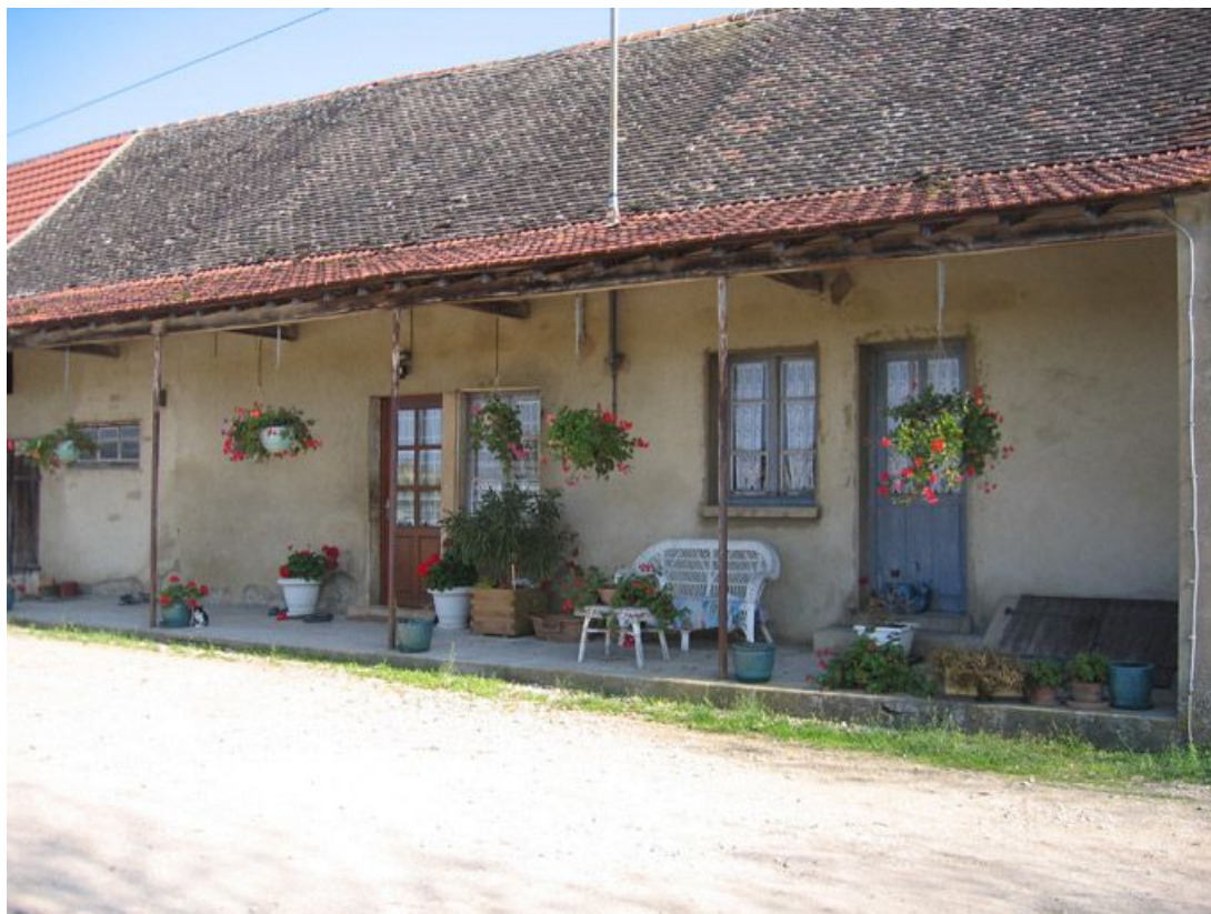
Vue d'ensemble de la façade.
