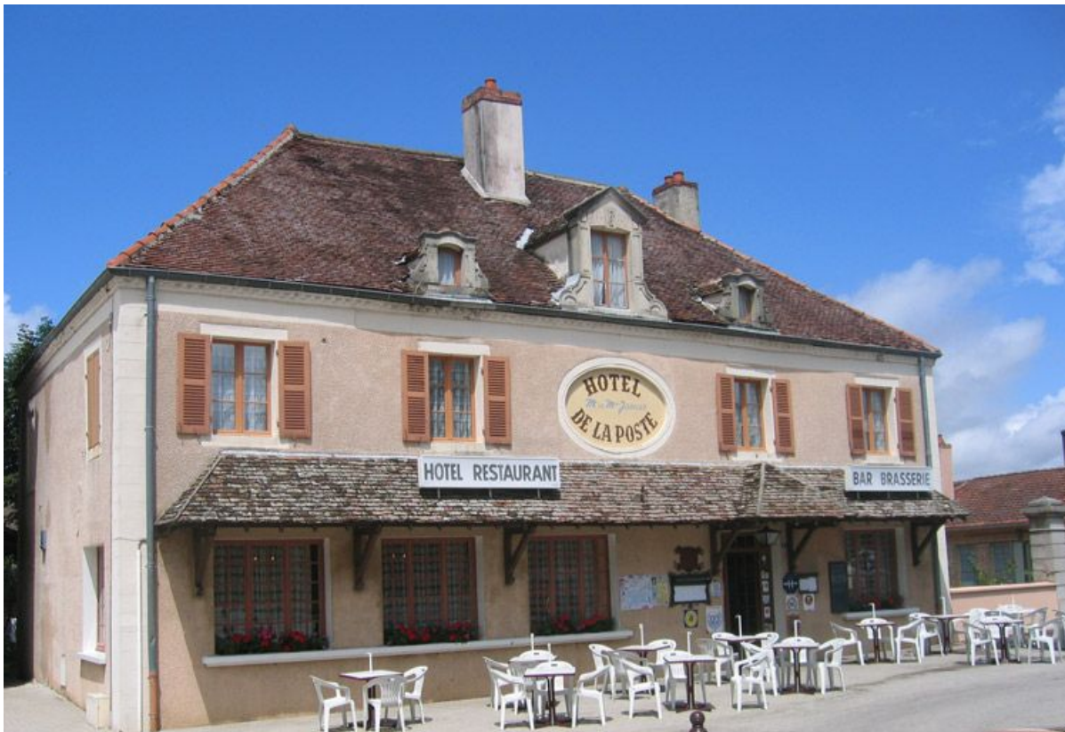
Vue d'ensemble de la façade.
