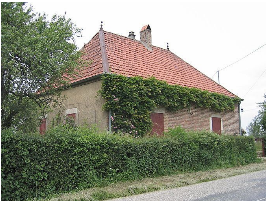
Vue d'ensemble de la façade de l'habitation.
