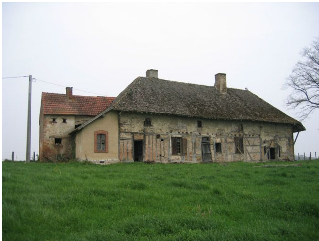
Vue d'ensemble de la façade de l'habitation.
