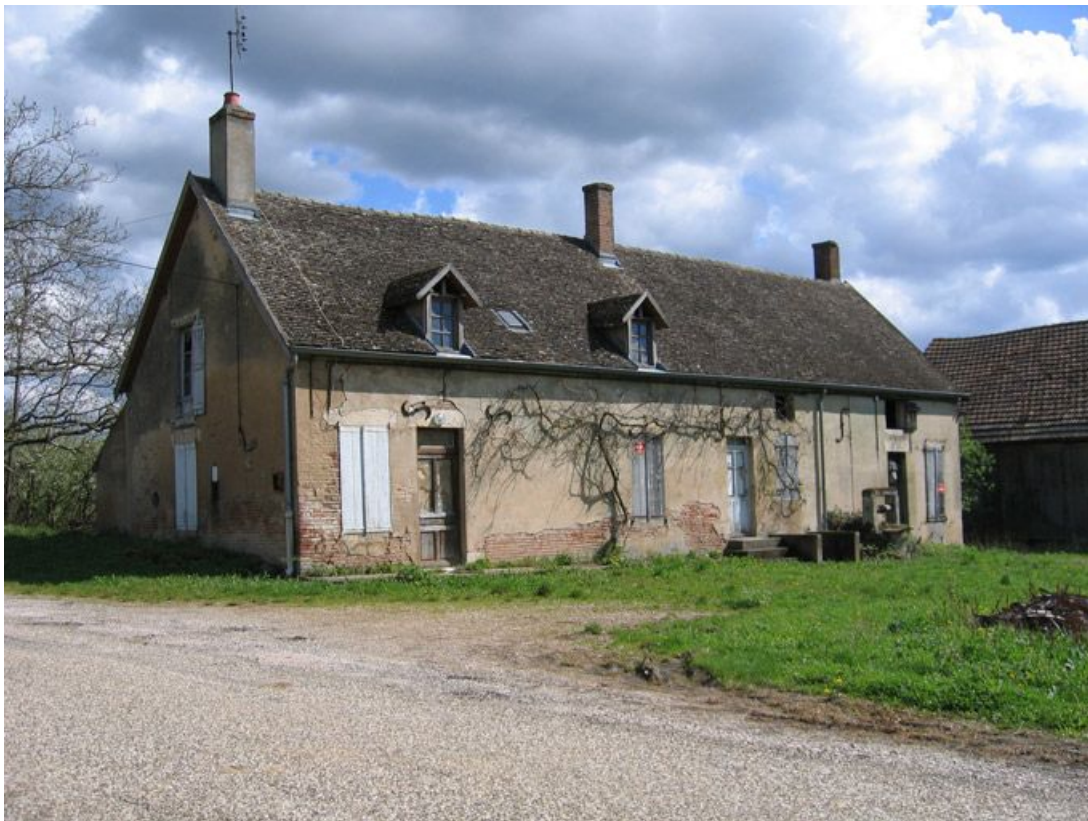
Vue d'ensemble de la façade.
