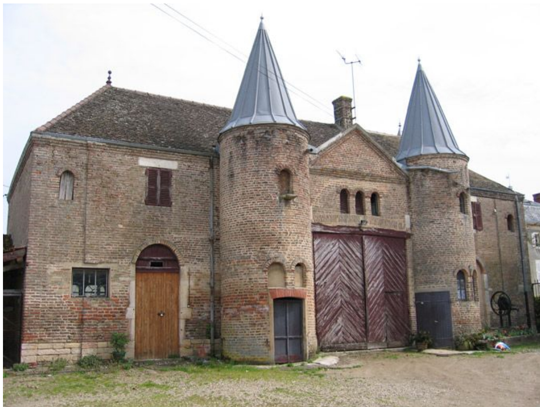
Vue d'ensemble de la façade.
