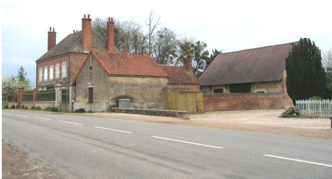
Vue d'ensemble de la façade.
