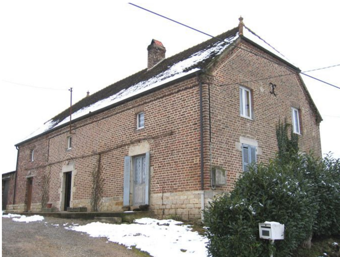
Vue d'ensemble de la façade.
