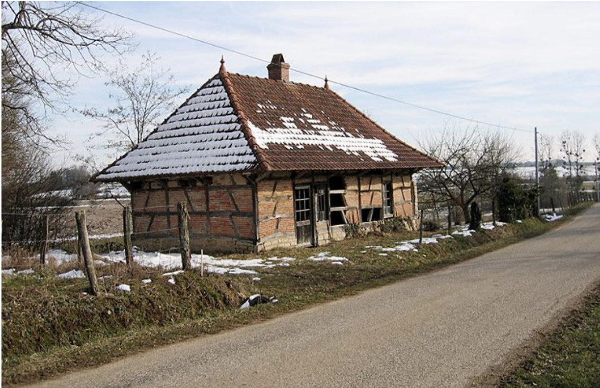
Vue d'ensemble de la façade.
