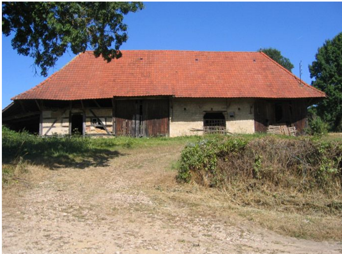
Vue d'ensemble de la façade.
