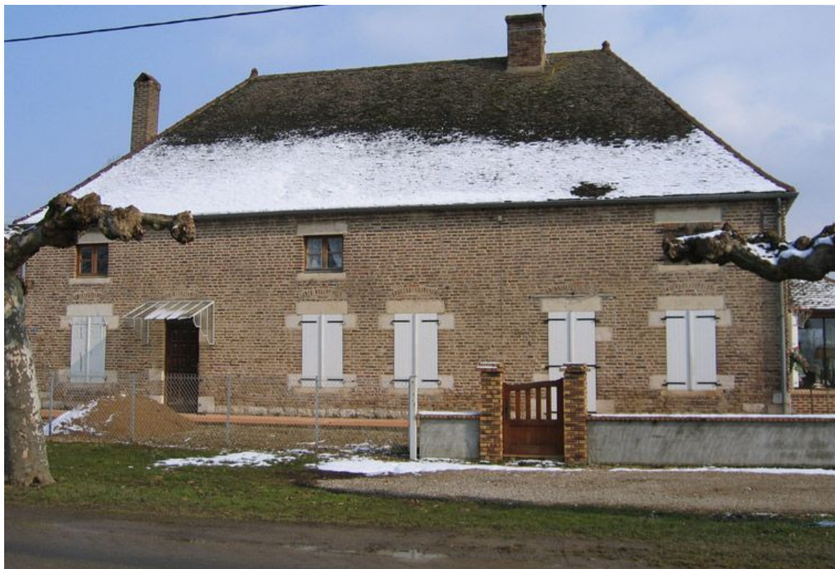
Vue d'ensemble de la façade.
