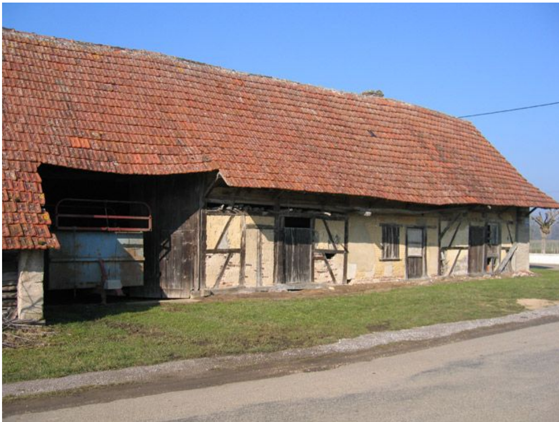
Vue d'ensemble de la façade.
