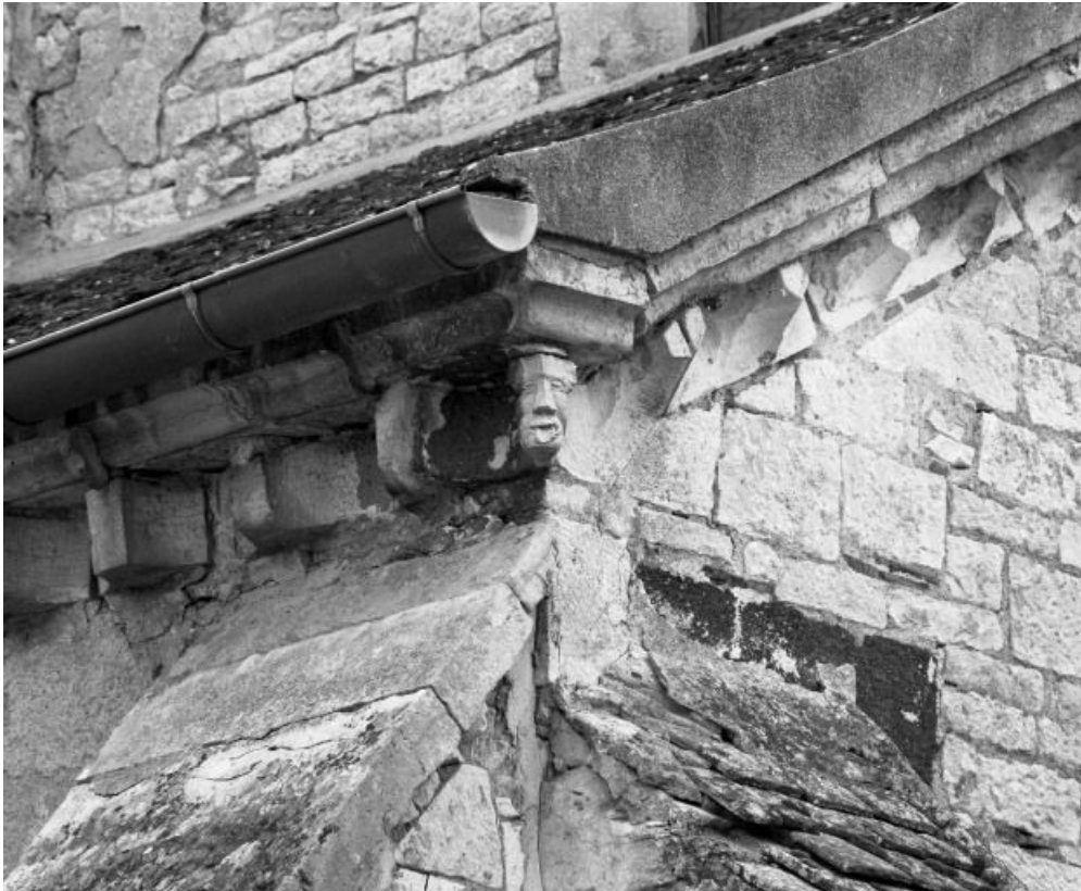
Façade : détail de l'angle du bas-côté gauche.
