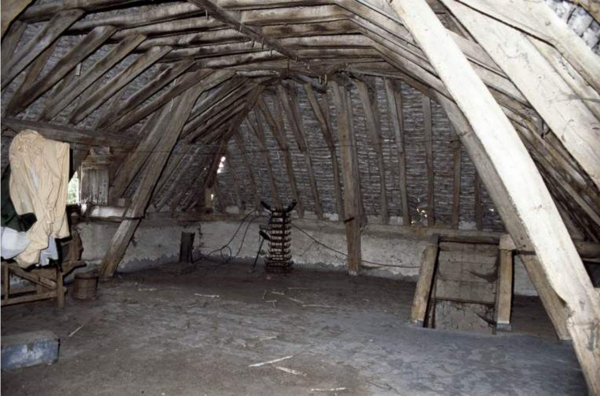
Logis secondaire, partie droite du comble.
