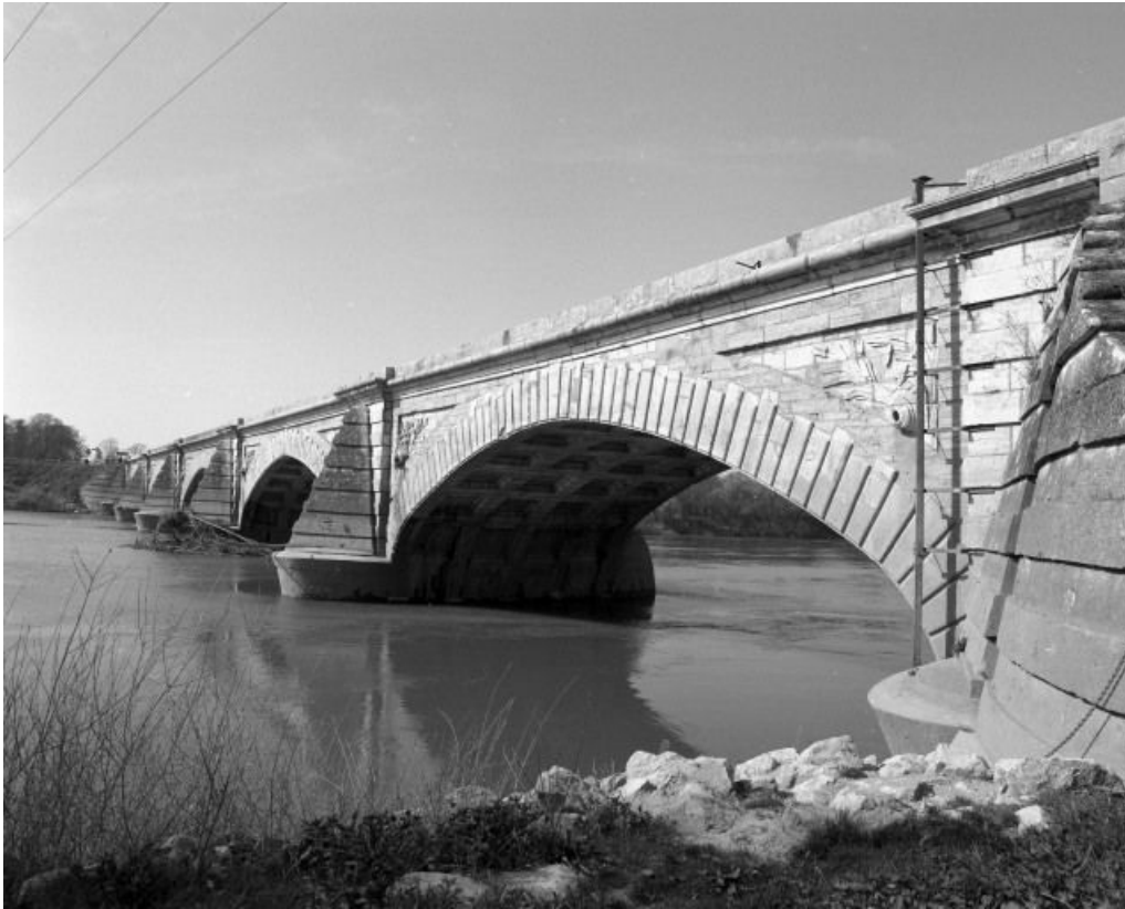
Vue d'ensemble rapprochée, en amont.
