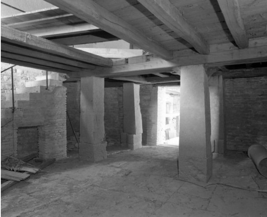
Bâtiment sud : rez-de-chaussée.
