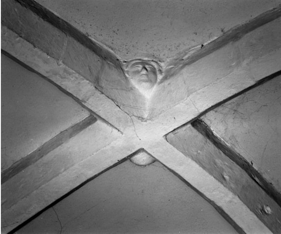
Bas-côté droit (sud), détail de la voûte.
