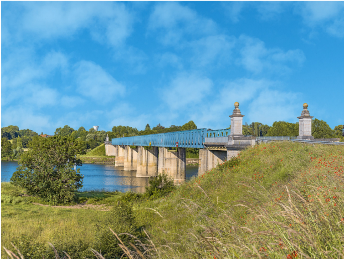
Vue d'ensemble du pont, d'aval.
