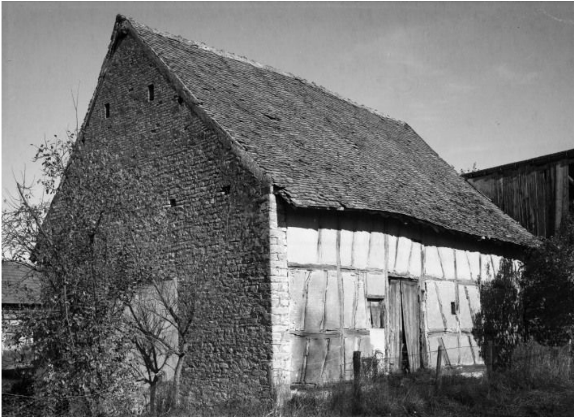
Bâtiment des dépendances.
