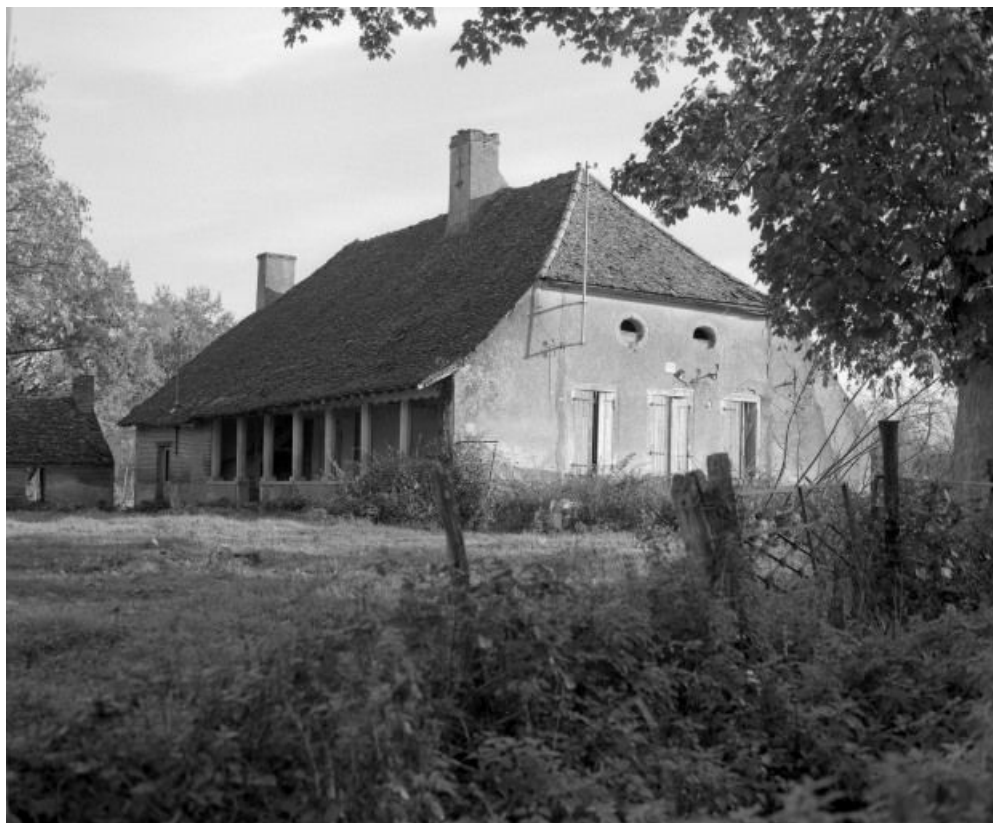
Logis : façade et élévation droite.
