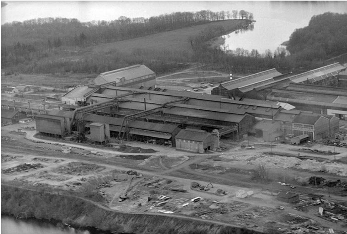
Vue aérienne de l'aciérie depuis le nord-est.
