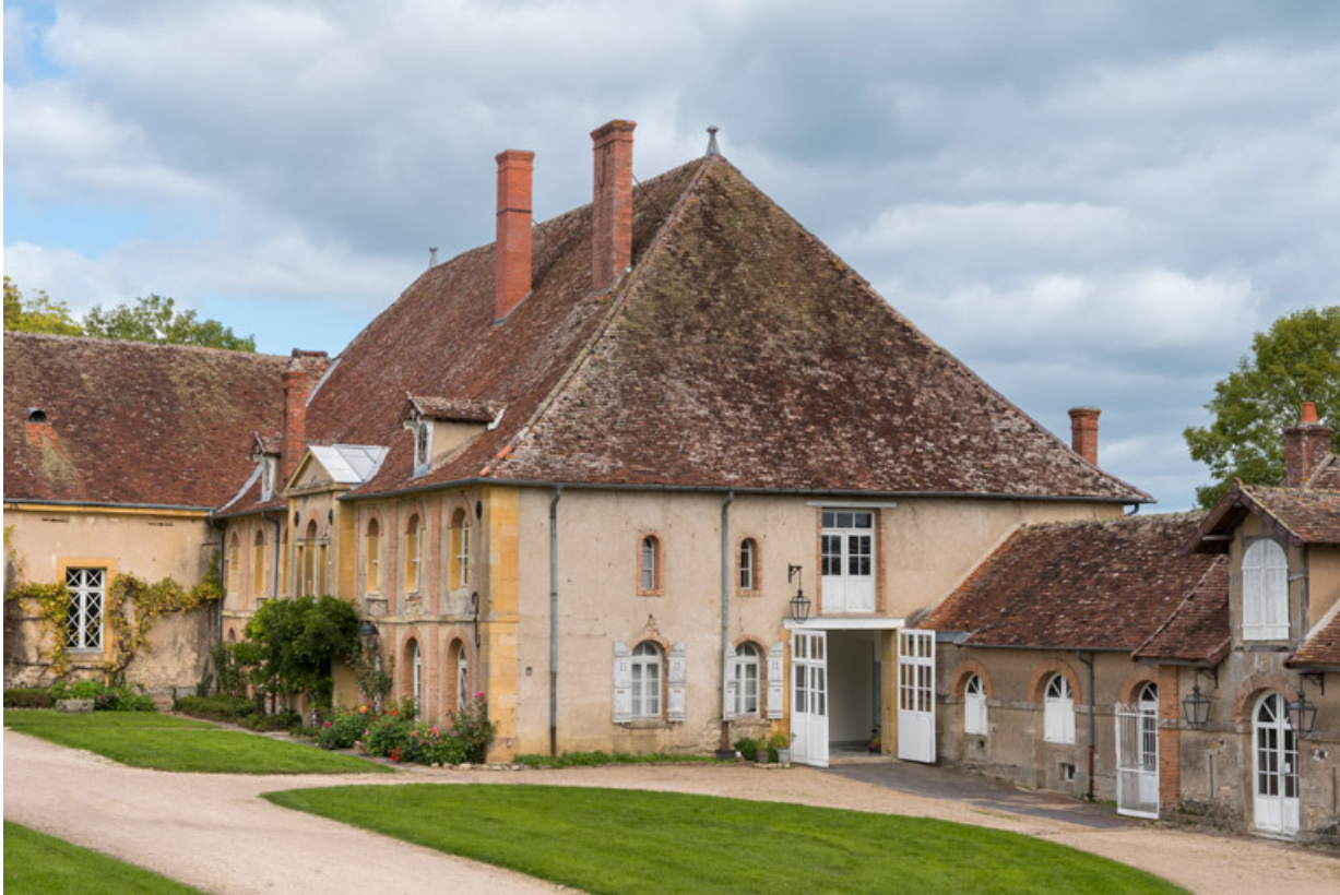
Façades antérieure et latérale droite.
