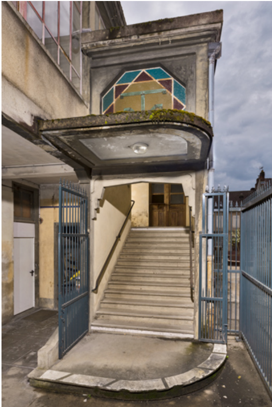
Cage de l'escalier principal.
