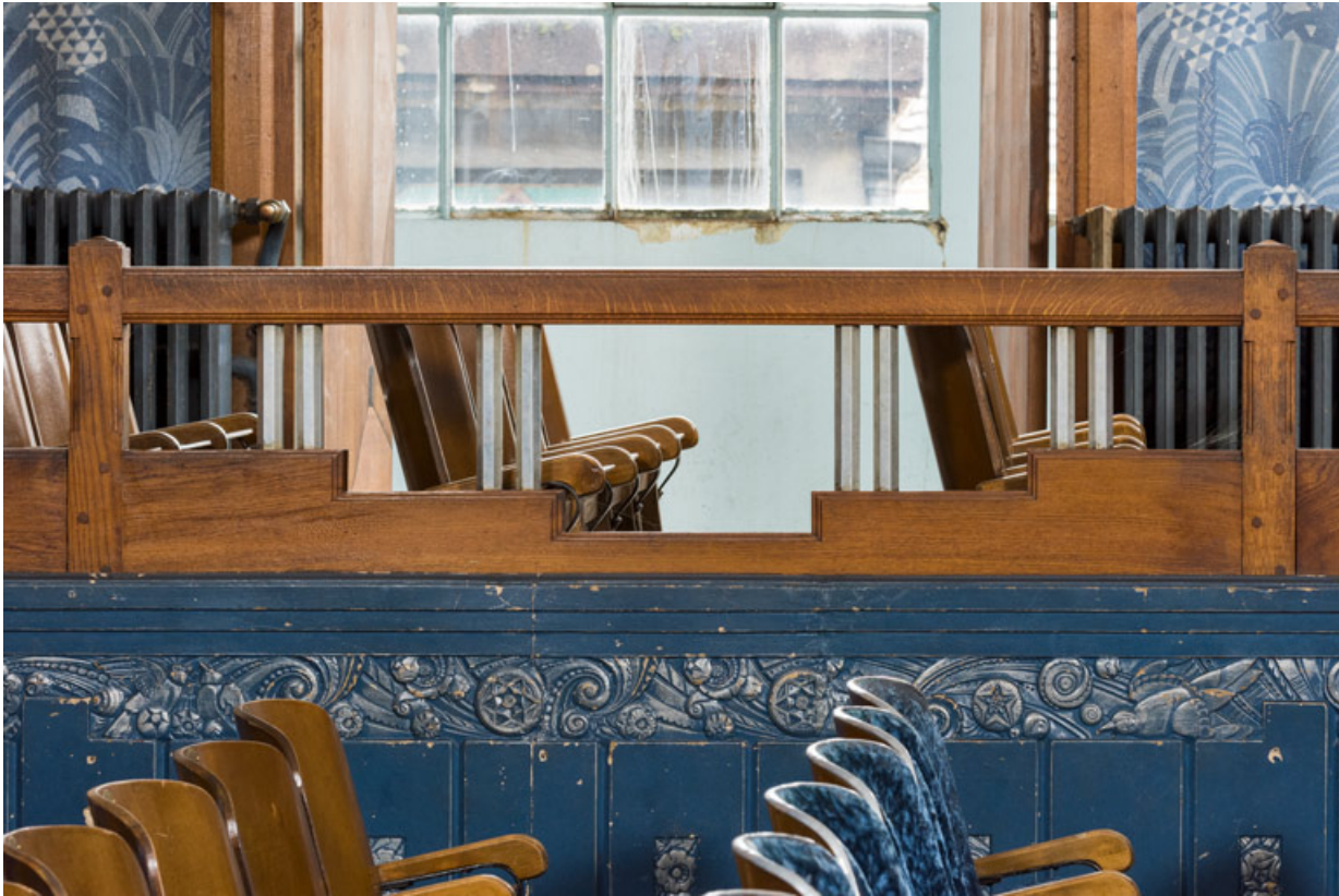
Salle, galerie côté jardin : détail du garde-corps.
