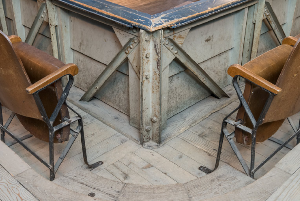
Balcon : structure métallique du garde-corps.
