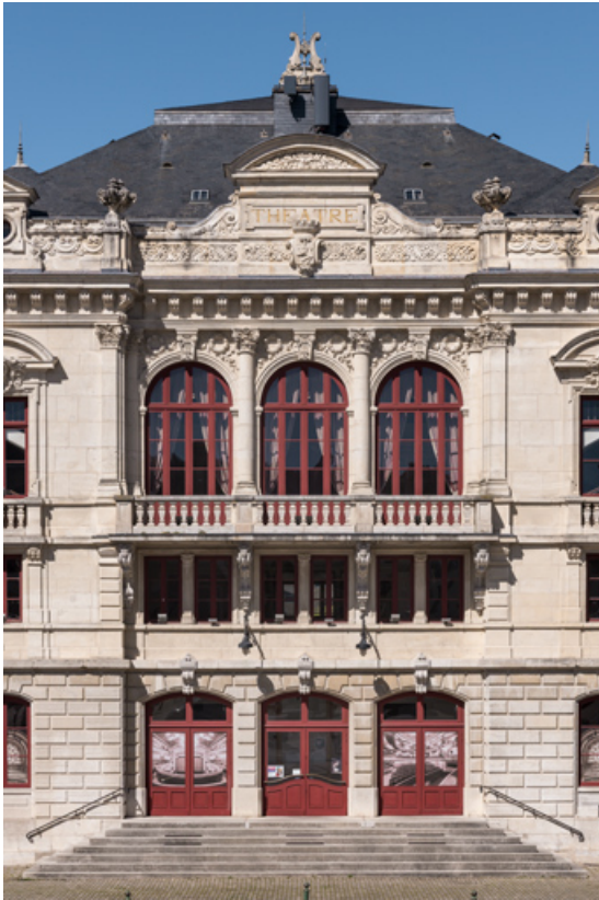
Façade antérieure : travée centrale.
