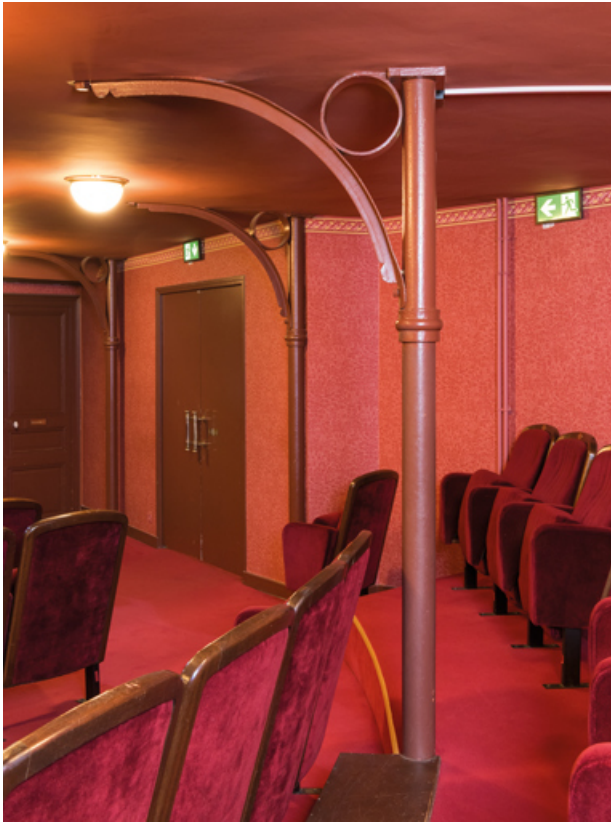
Poteaux métalliques supportant le 1er balcon.
