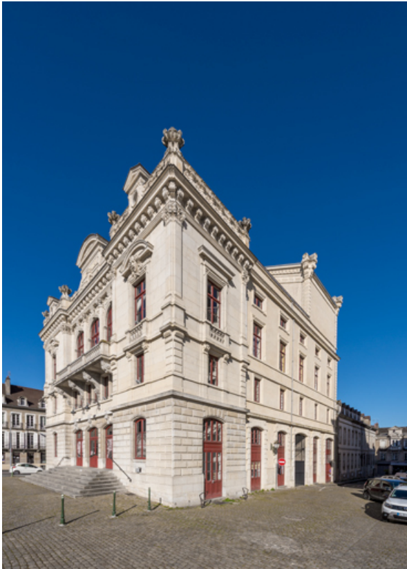
Façades antérieure et latérale droite.
