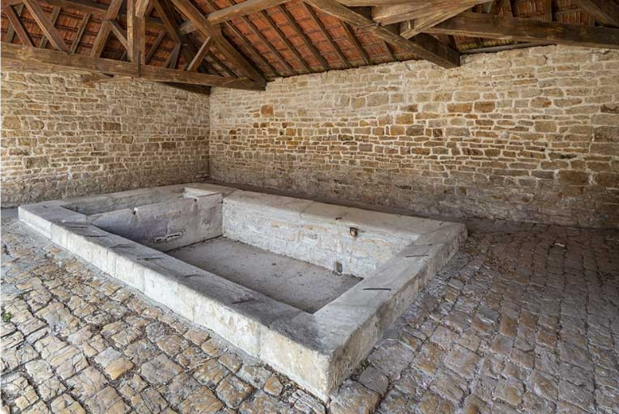
Les deux bassins du lavoir.
