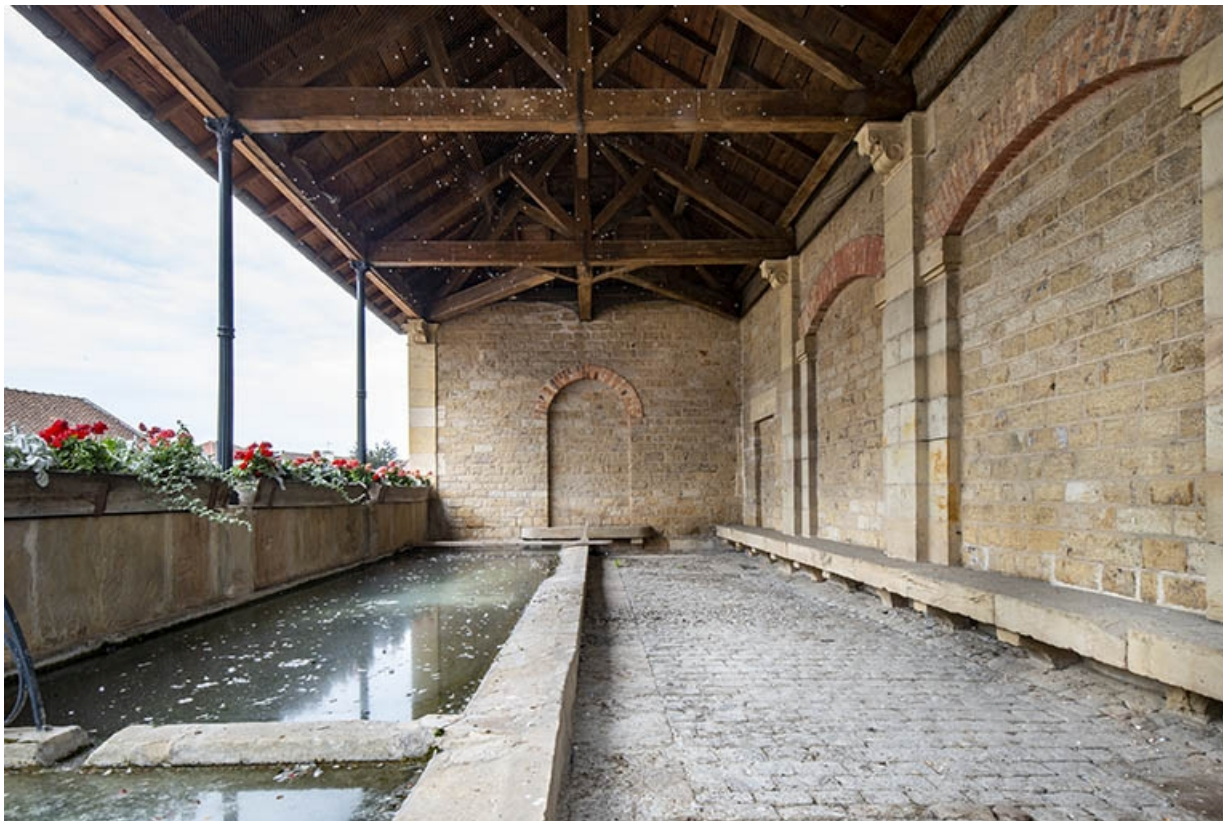
L'intérieur de la fontaine-lavoir, depuis l'entrée.
