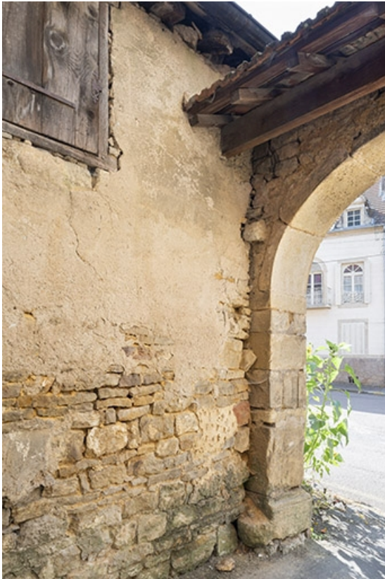
Détail de maçonnerie depuis la cour.
