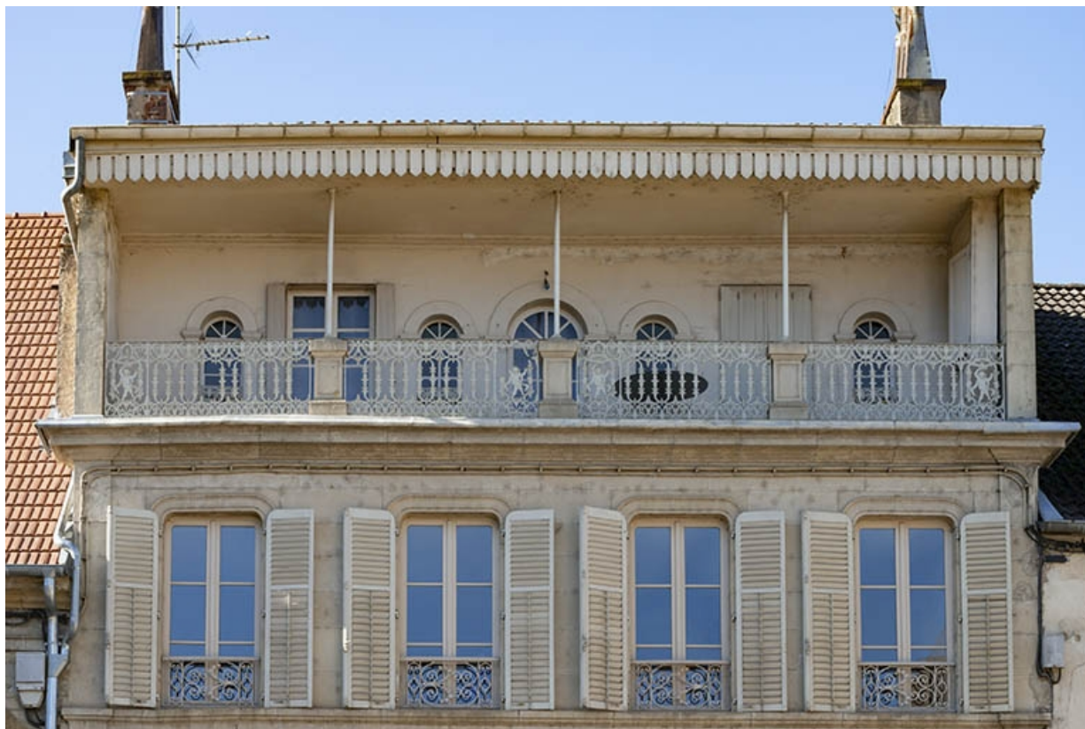
Détail des deux derniers niveaux.
