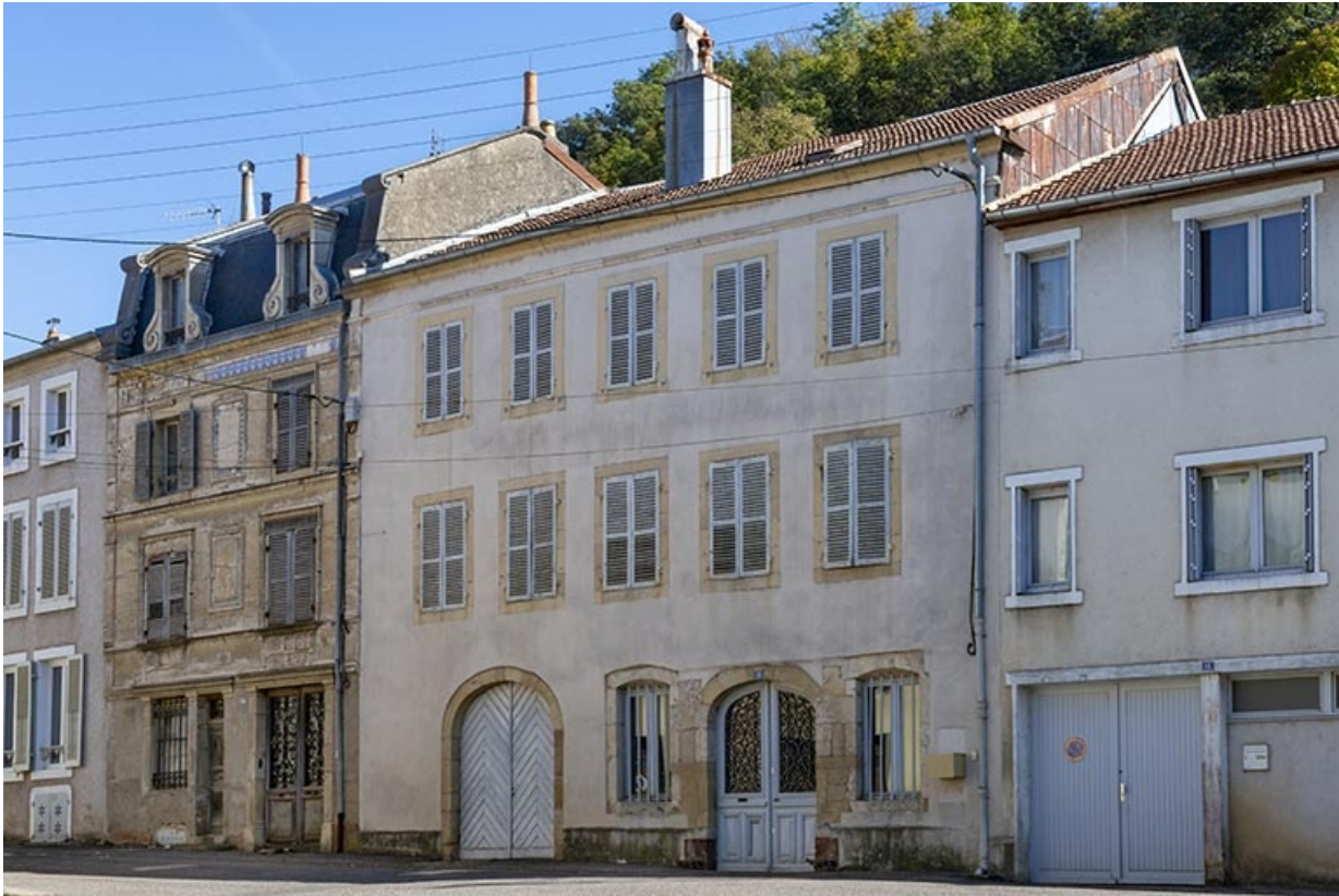
La façade dans son environnement urbain.
