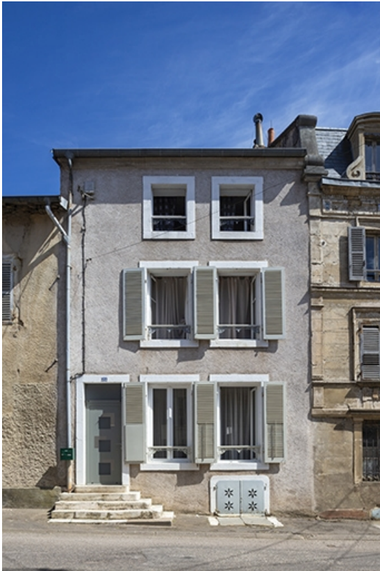
Rue Thiers, façade de la maison n° 22.
