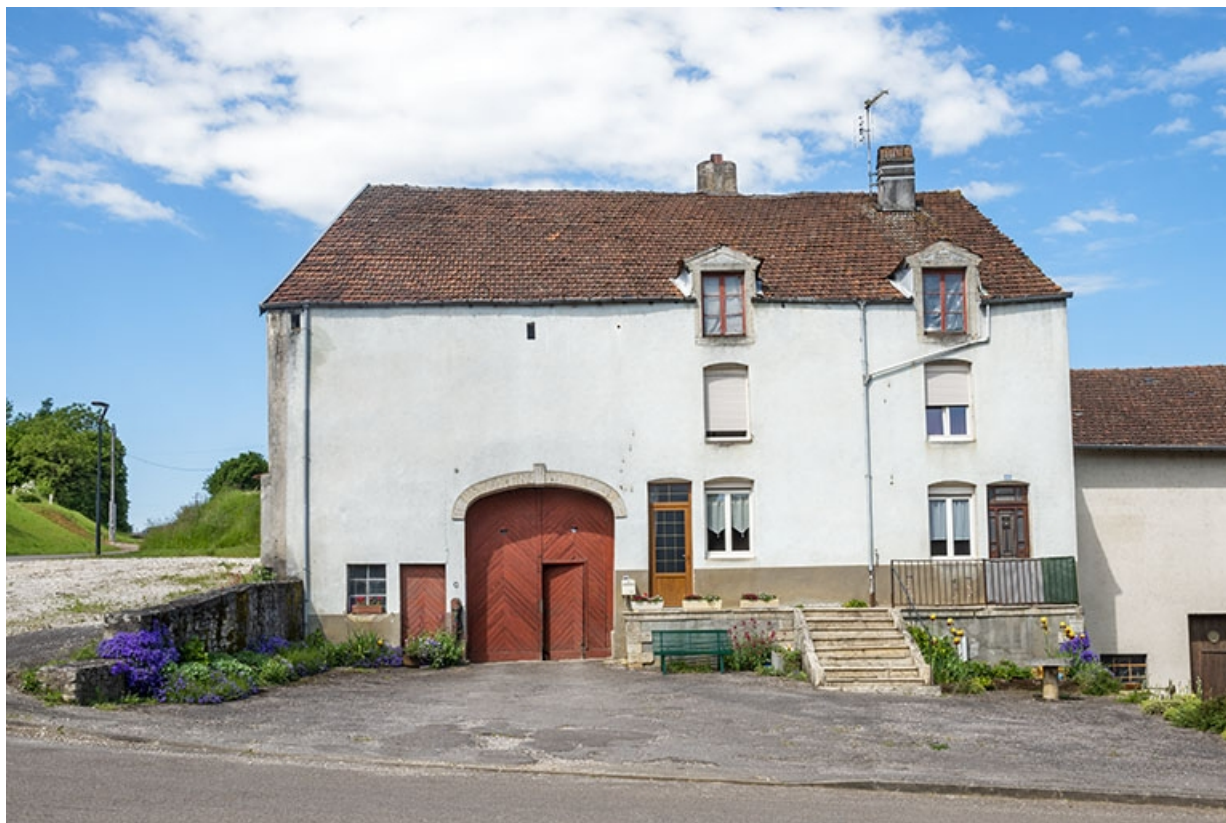
La façade antérieure depuis la rue.
