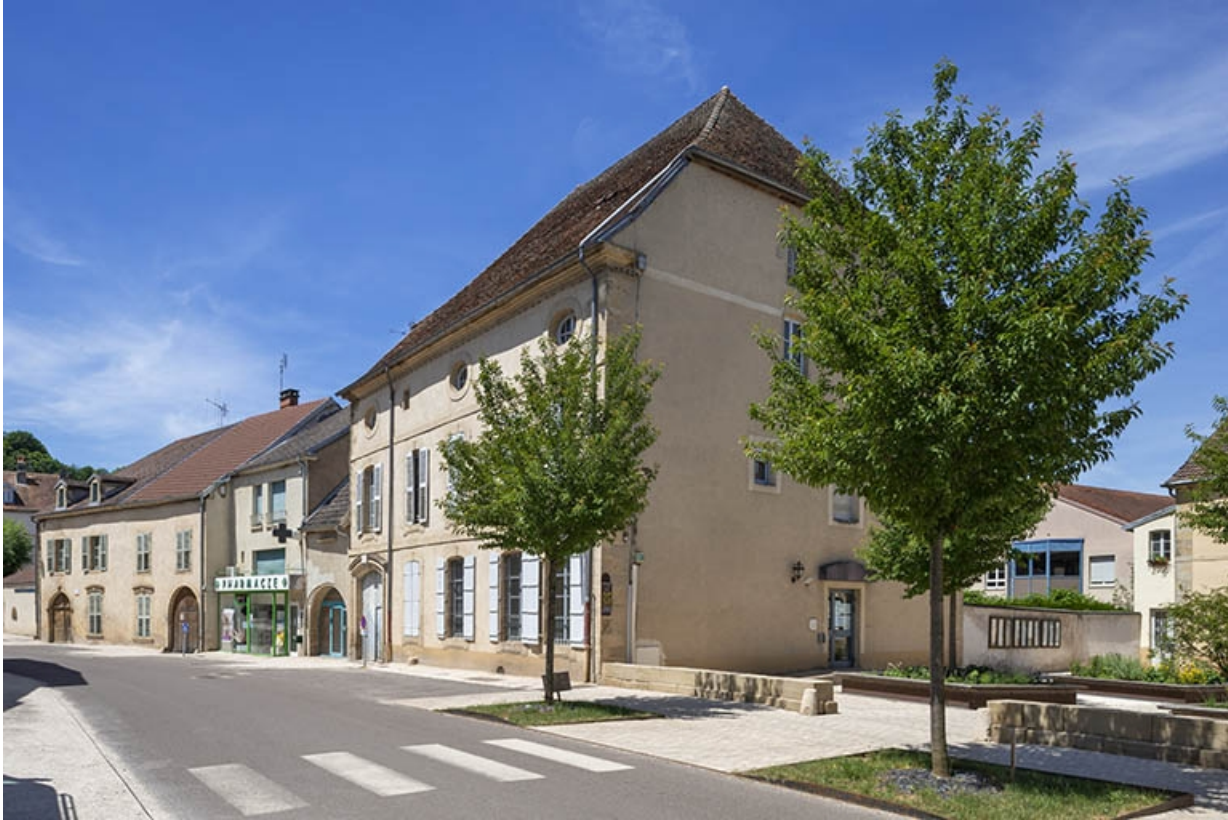
Le bâtiment de trois quarts droite.
