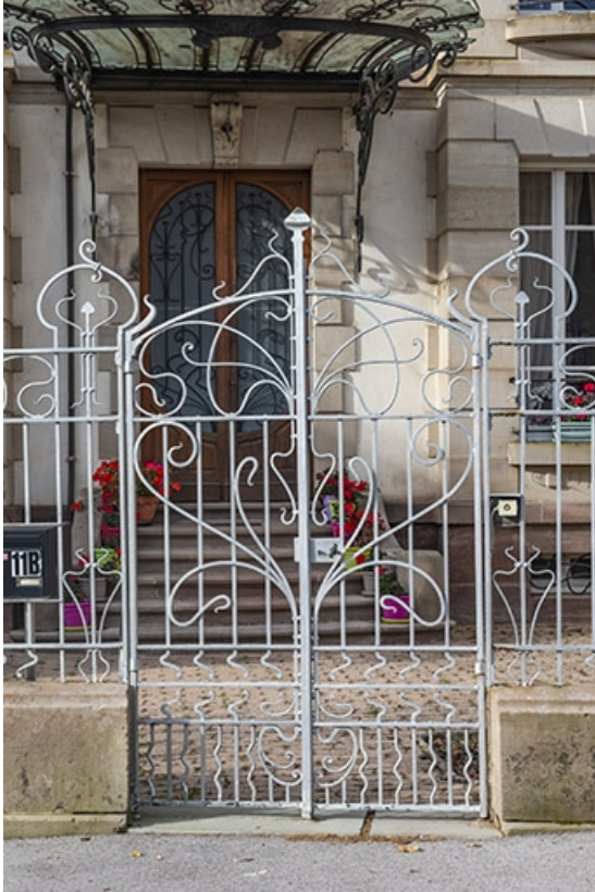
Grille de clôture.
