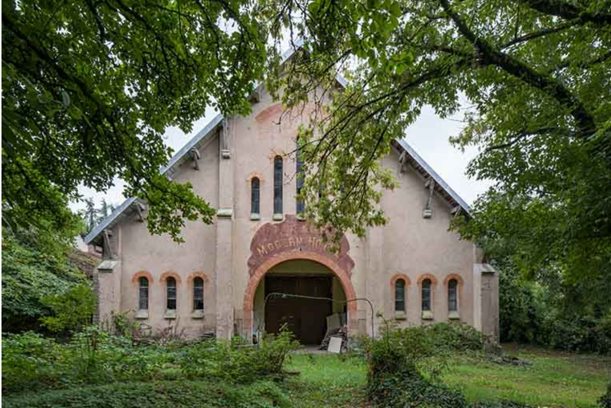
Mur-pignon nord, vue de face.
