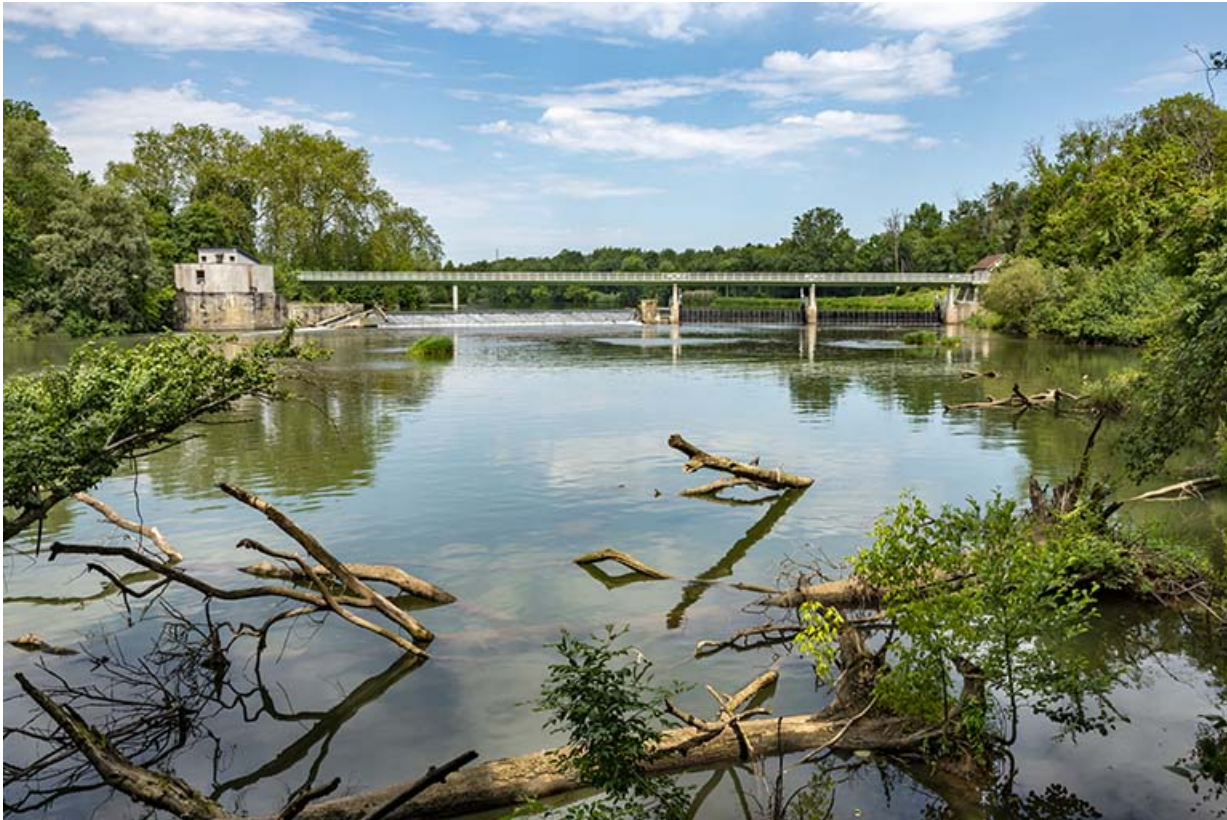
Vue générale depuis l'aval.
