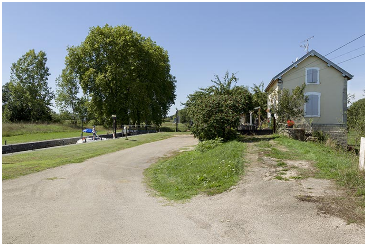
Vue depuis l'amont.
