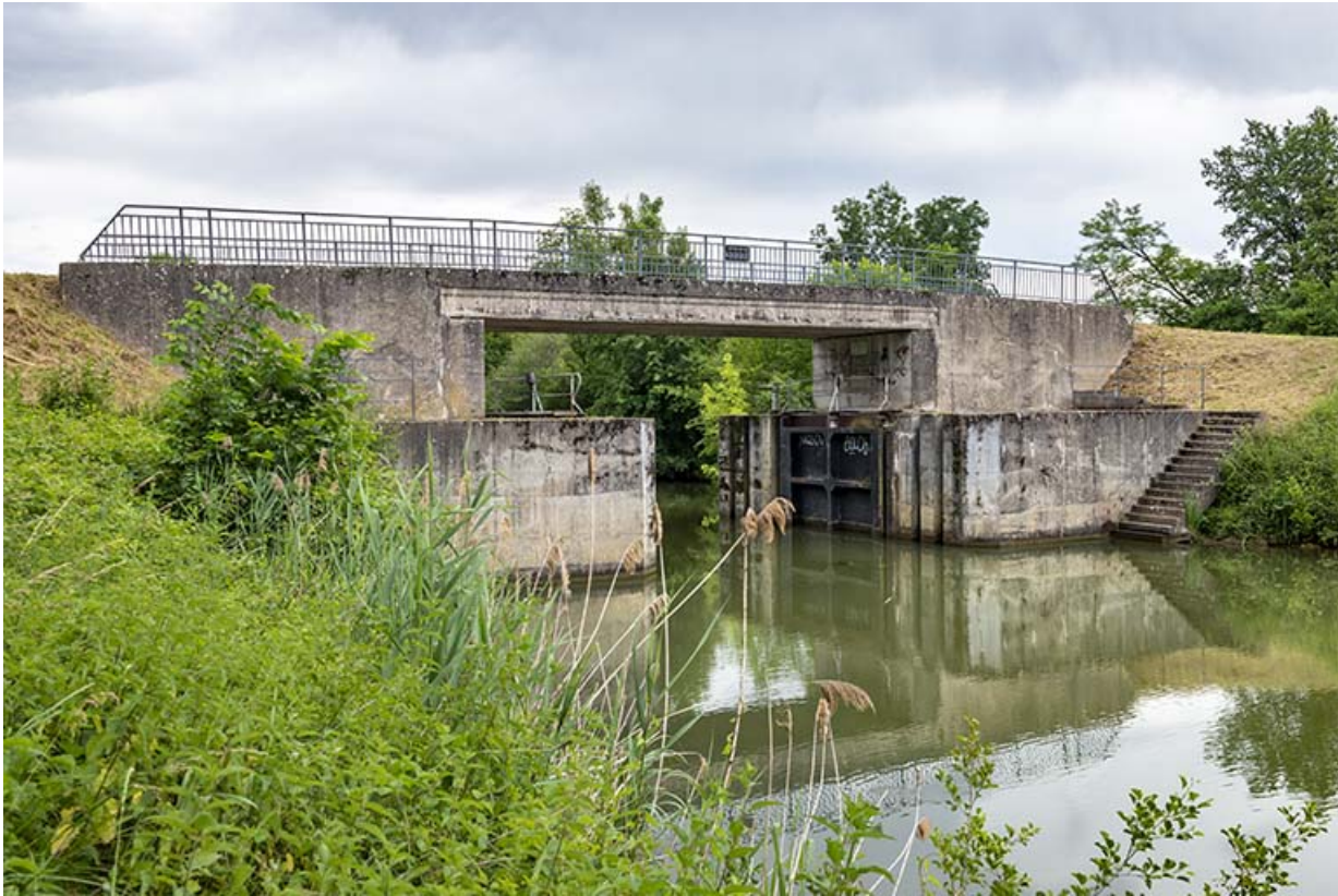
Vue aval de la porte de garde.
