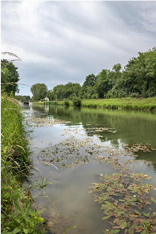
le canal de navigation, vue vers l'aval.
