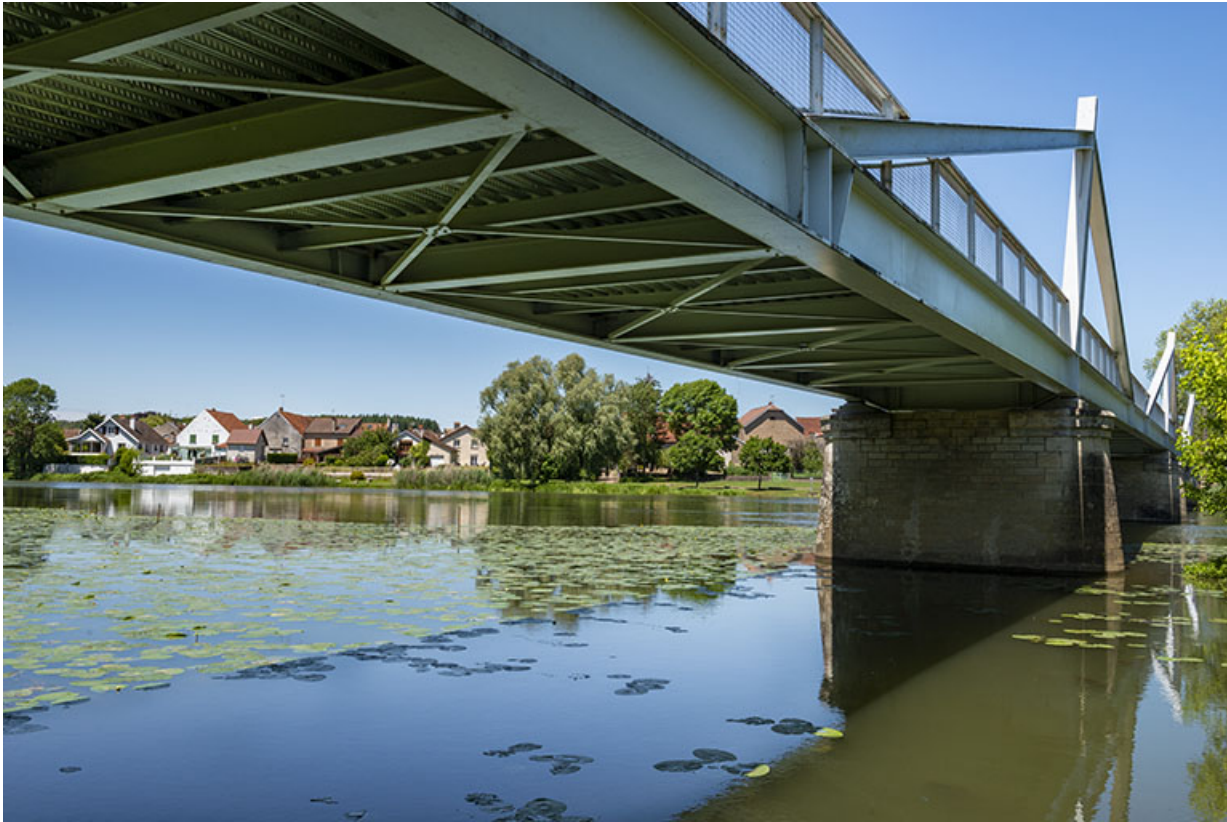
Tablier métallique du pont.
