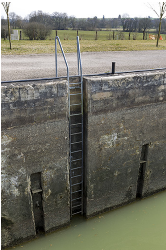
Bajoyer de l'écluse.
