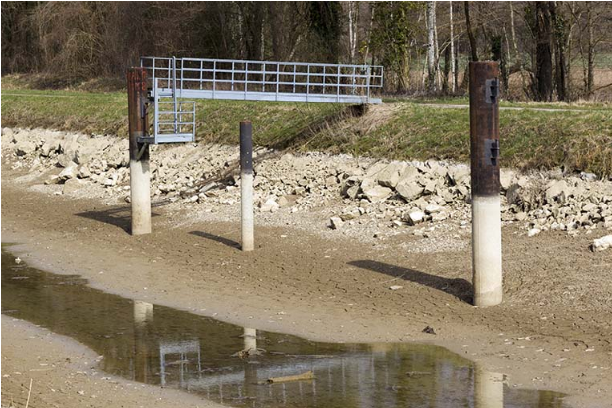
Curage du canal de navigation.
