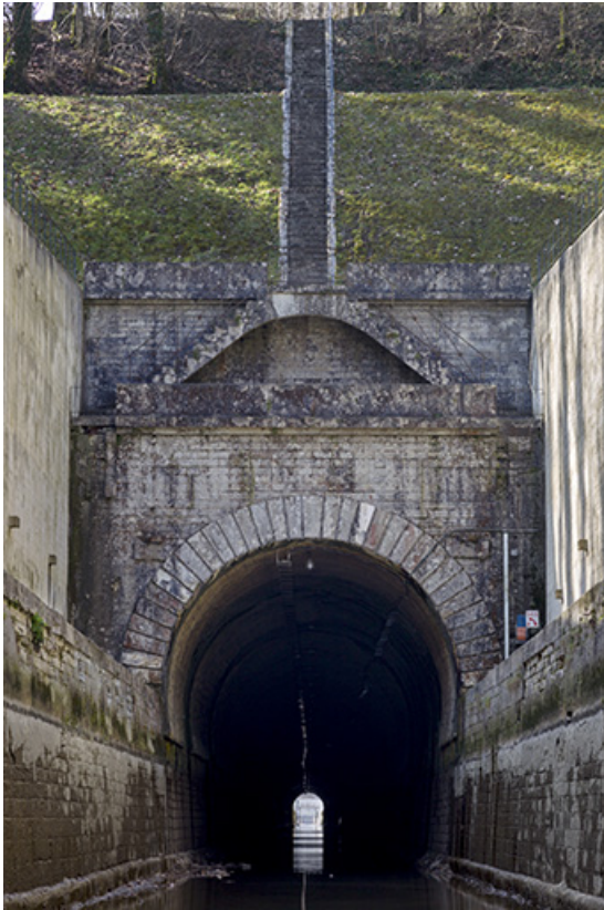
Entrée amont du souterrain.
