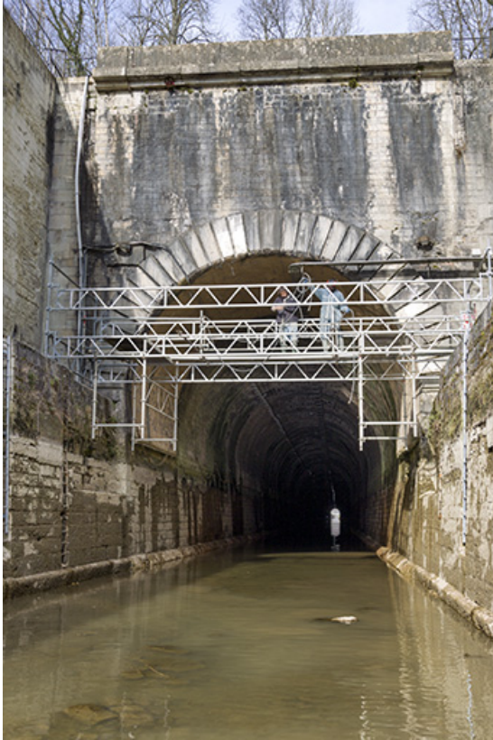
Entrée aval (restauration de la maçonnerie 2015). 70, Savoyeux
